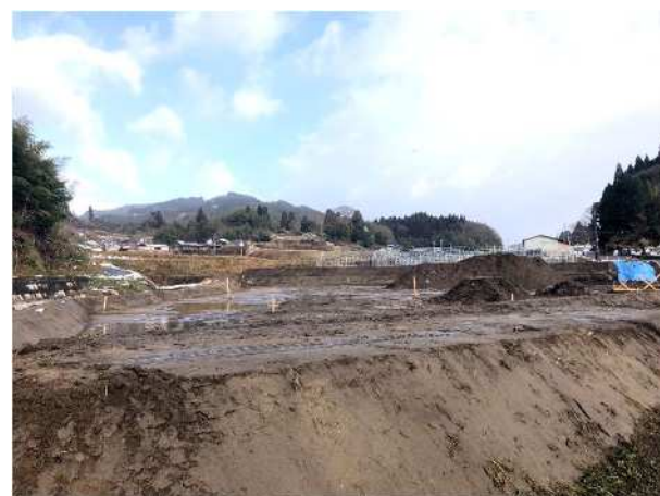
写真 34 圃場整備工事 (福塚地区)
