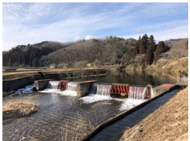
写真 18 印賀川夏日堰 (印賀地区)
