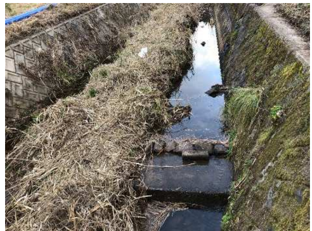
写真 56 河川締め切り後の巣穴発見時 河川水位低下への配慮（町内河川）
