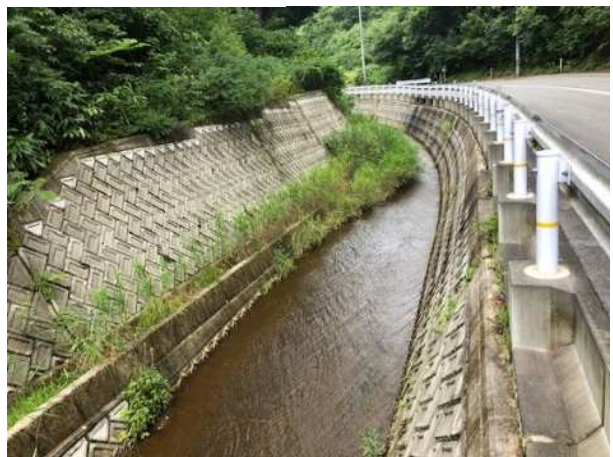
写真 50 熊谷川の護岸整備区間（福寿実地区）
