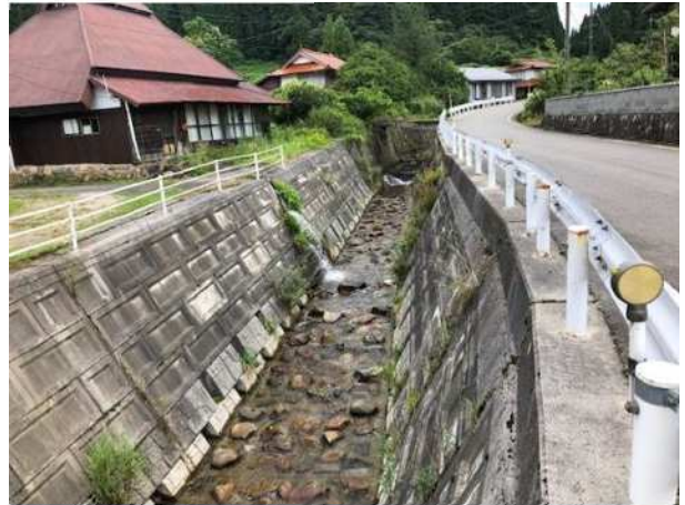
写真 49 神戸川の護岸整備区間（神福地区）
