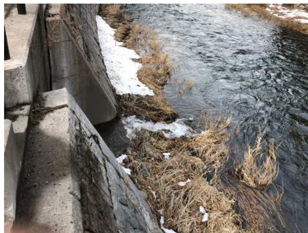
写真 32 段差への寄せ石例
