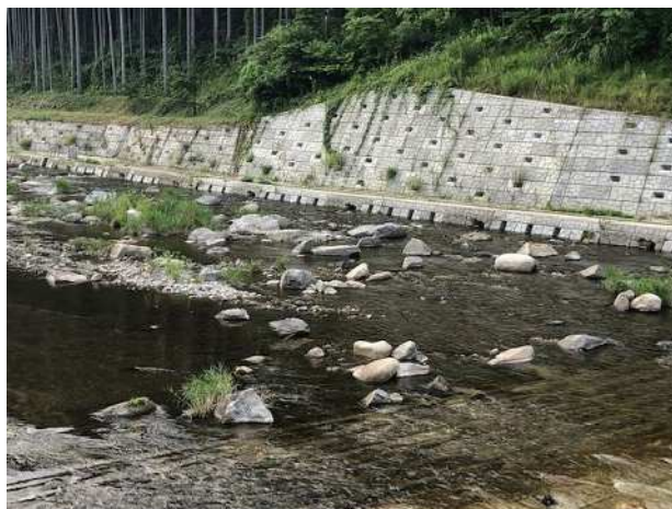
写真 27 護岸整備工事（霞地区 日野川）
