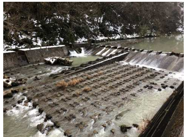
写真 30 床止め工事（河上地区 日野川）
