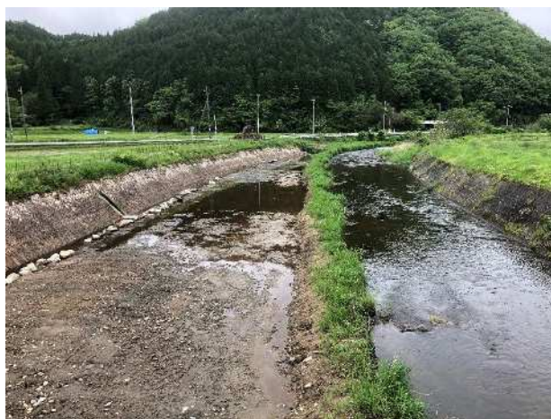
写真 28 河床掘削工事（萩原地区 日野川）
