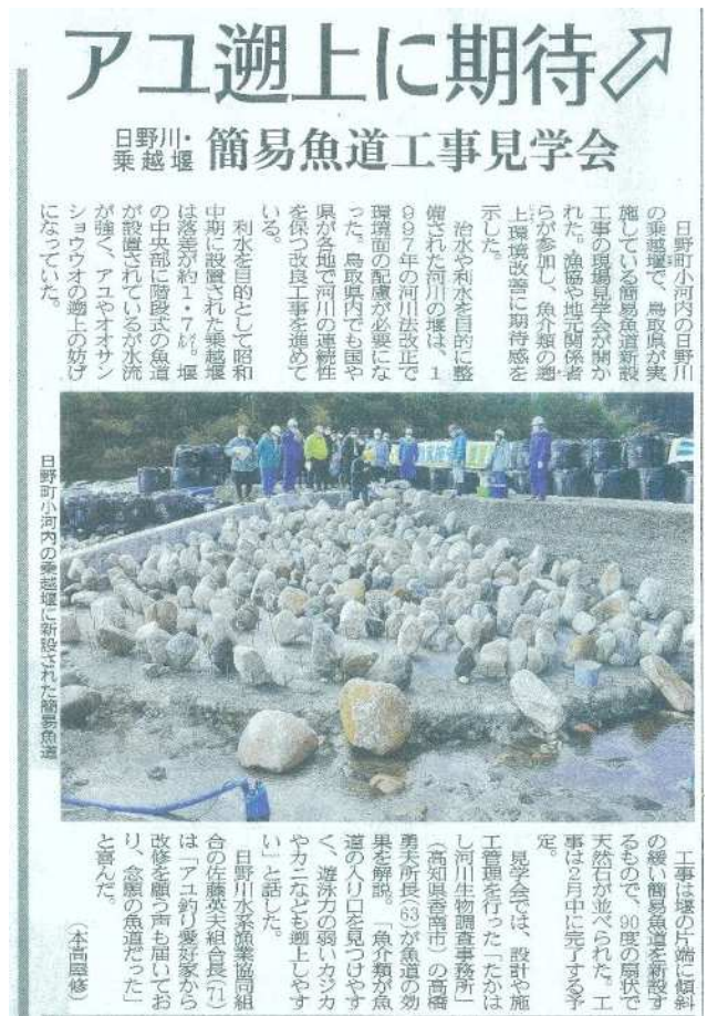
写真 36 簡易魚道の設置工事 (日野町小河内)
