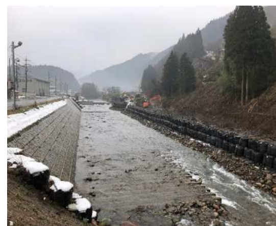
写真 38 土嚢締め切り（丸山地区 日野川）
