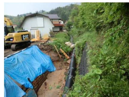
写真 39 土嚢締め切り（折渡地区 坂原川）
