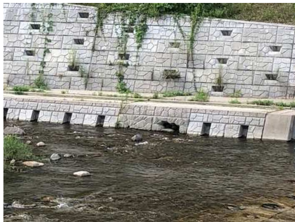
写真 51 オオサンショウウオ巣穴ブロックと魚巣ブロック（丸山地区 日野川）
