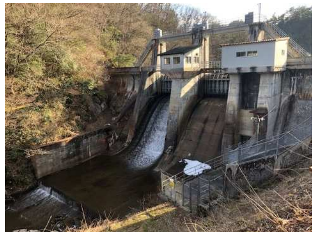
写真 19 大宮ダム (菅沢地区)
