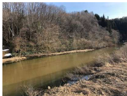
写真 42 河床に堆積した土砂 (印賀川)
