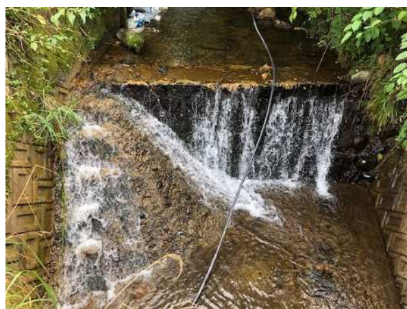
写真 61 垂直落差に設置されたスロープ（神福地区 神戸川）
