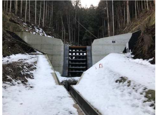
写真 29 透過式砂防堰堤（萩原地区 寺奥谷川）
