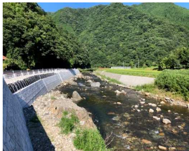
写真 31 道路工事に伴う護岸整備
