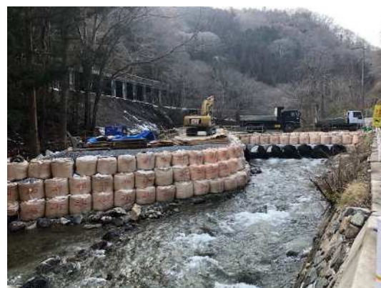
写真 37 河川横断工（岡山県新見市 西川）
