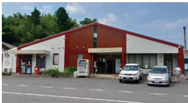
改修工事費の全額を町が負担していた阿毘縁会館
