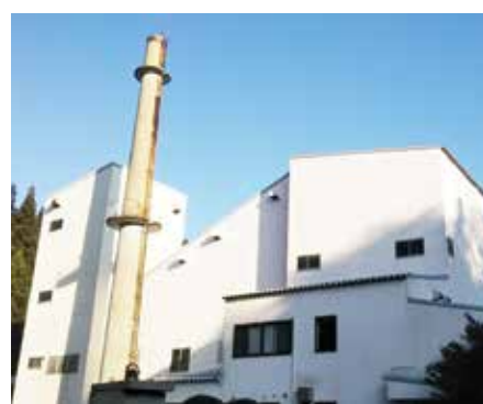
広域化対象の可燃ごみ処理施設
