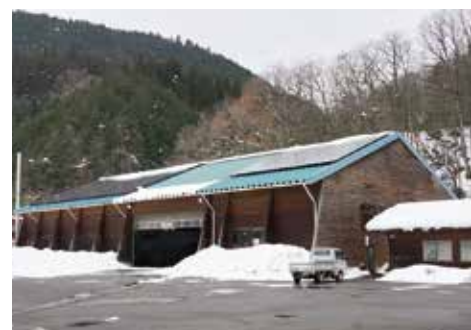
プレカット上屋に設置されている太陽光パネル
