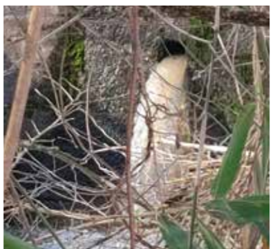
セントラル農場から流出する汚水
