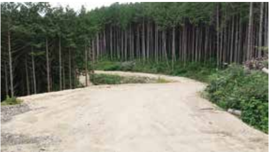
林道内方線開設工事（2工区）の現場
