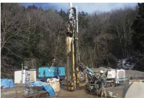
水源の試掘工事
