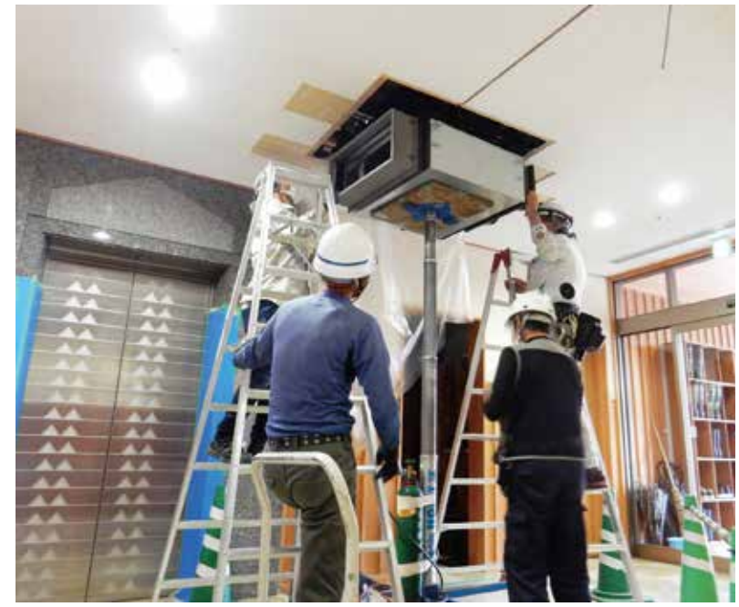
庁舎空調設備改修工事
