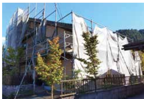
改修中の住宅
