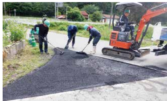
委託業者による町道修繕工事
