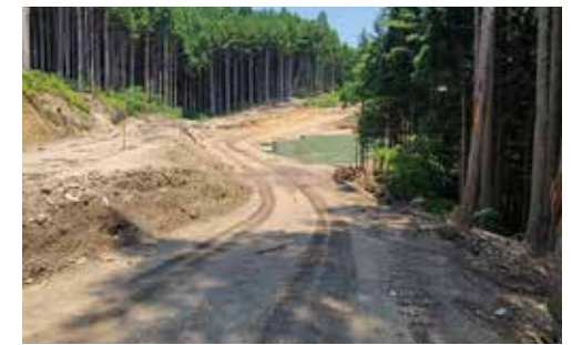
内方線開設工事現場
