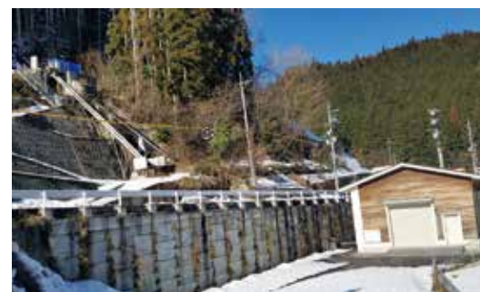
新石見小水力発電所
