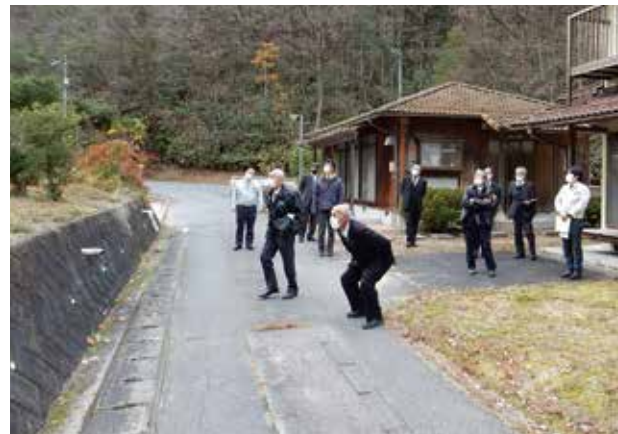
きりしま団地の屋根の状態を調査
