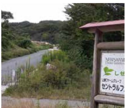
解体された農場建屋
