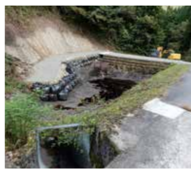
土砂の浚渫が完了した沈砂池
