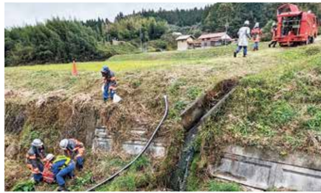
吸管届かず可搬ポンプを移動
