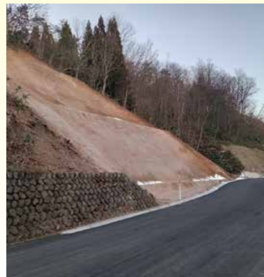
変更された法面工事
