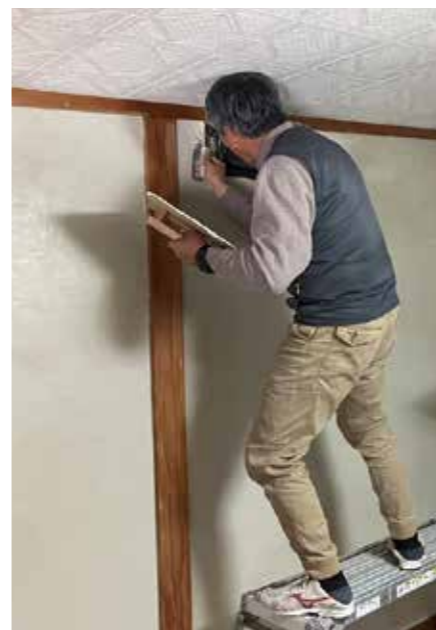
改修中の住宅（生山）
