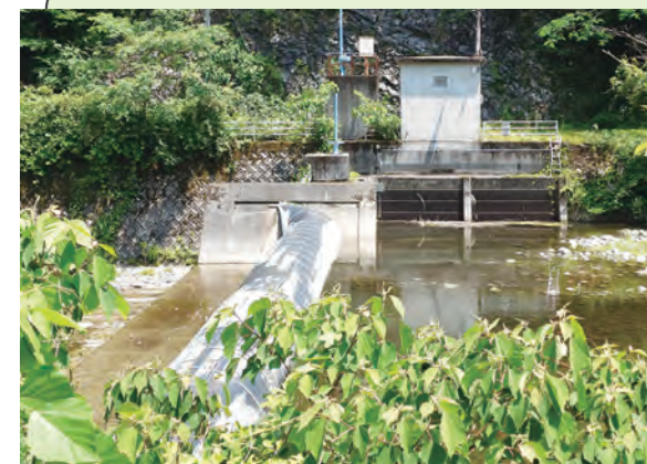
改修が予定されるゴム堰
