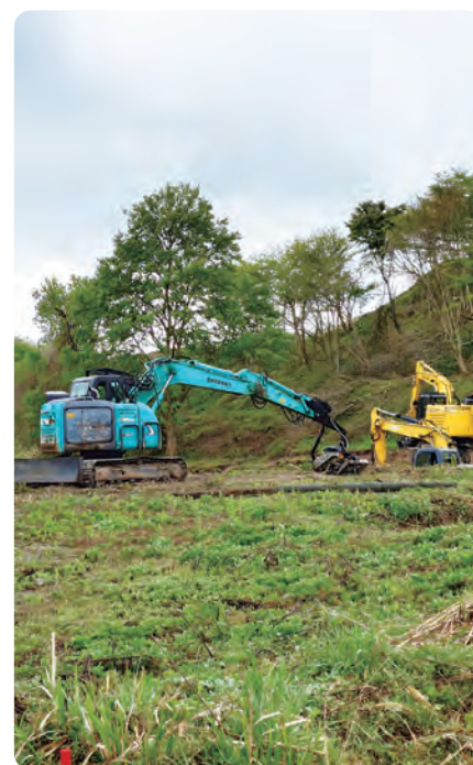
農場造成工事始まる
