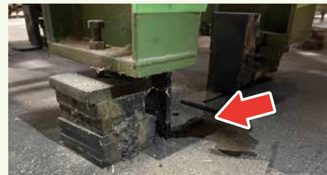
嵩上げによる地盤沈下対策
