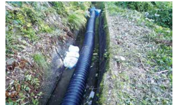
漏水箇所へ仮設パイプ設置
