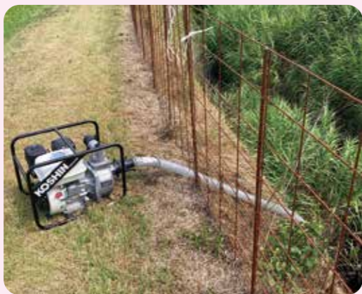
湧水対策で導入したポンプ
