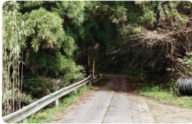
町道に覆い被さった樹木(上萩山地内)
