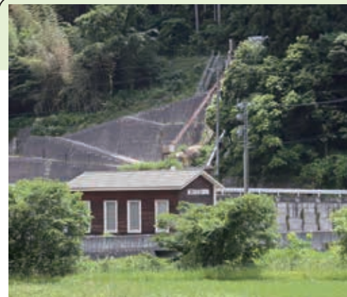
再開された新石見小水力発電所
