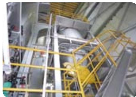
修繕する排ガス処理施設
