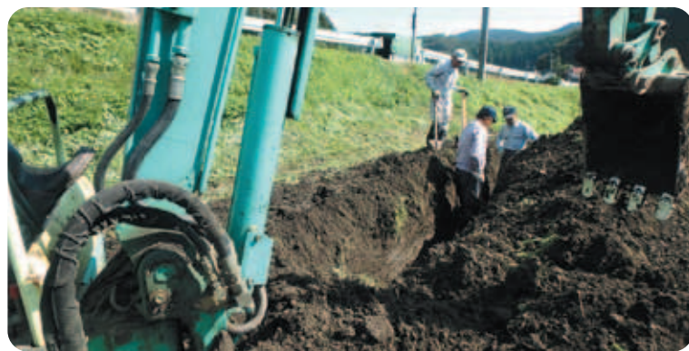
圃場の排水工事
