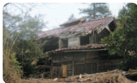
補助金で解体される家屋
