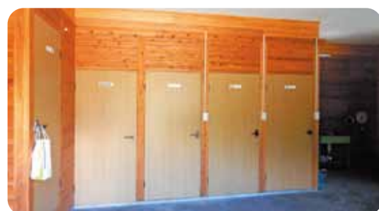
改修された研修棟トイレ
