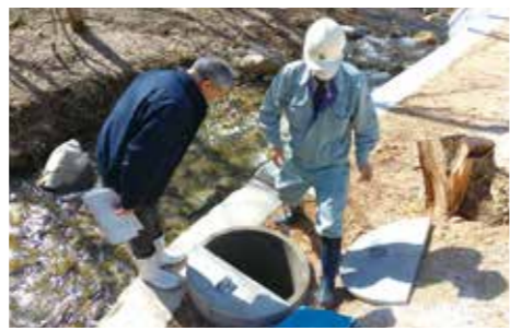
人工巣穴を設置した護岸工事
