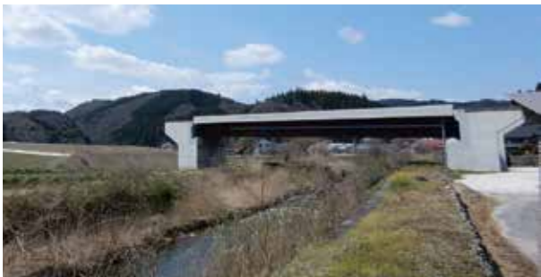
建設が進む鍵掛峠道路
