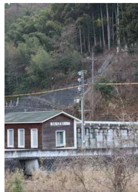
再稼働した新石見小水力発電所
