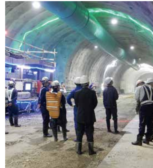
広島県側のトンネル工事
