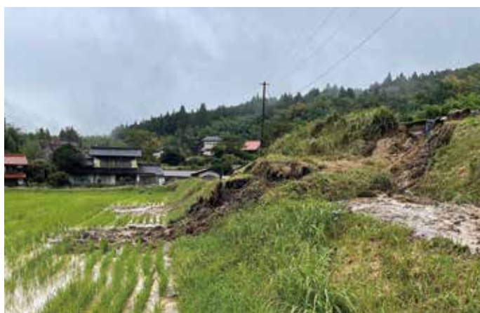
豪雨による畦畔の崩壊(下石見)
