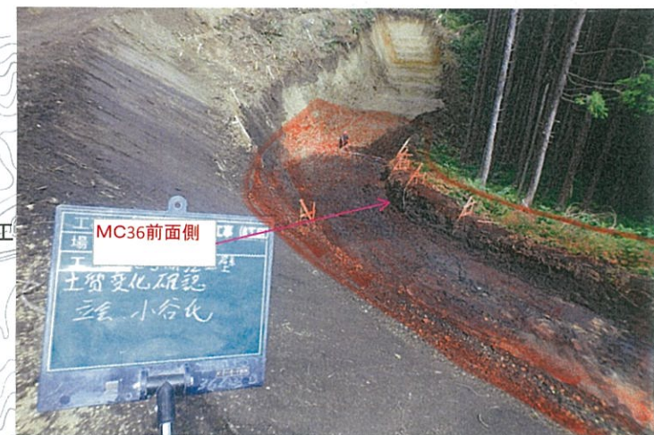
地盤改良箇所
