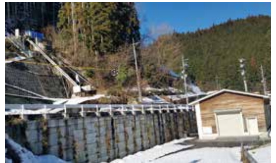
新石見小水力発電所
