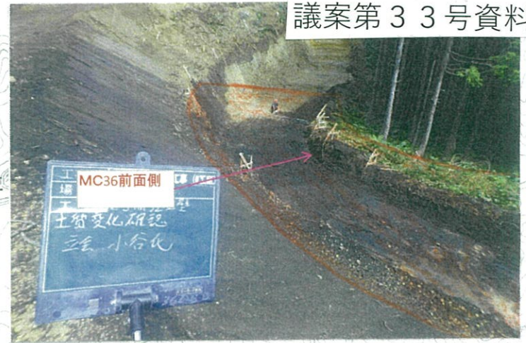
地盤改良箇所
