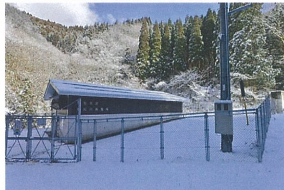
若松川発電所（日南町湯河）
