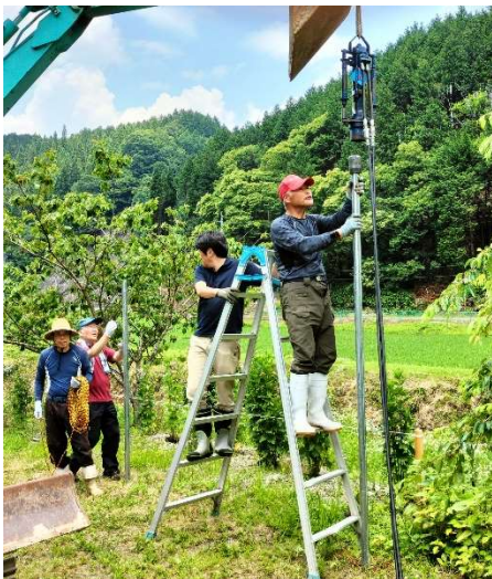
遮光ネット設置
