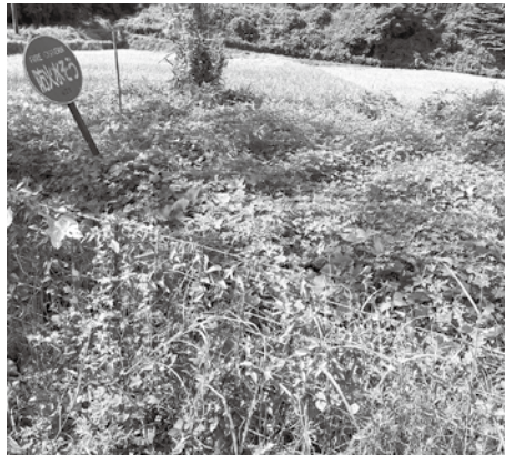
草に埋もれた防火水槽
