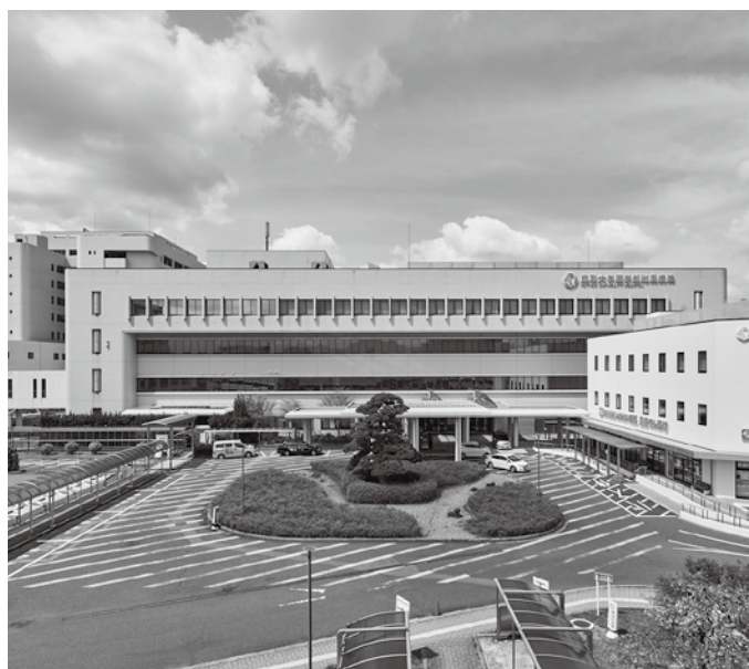
2029年に再整備予定の鳥取大学医学部附属病院
