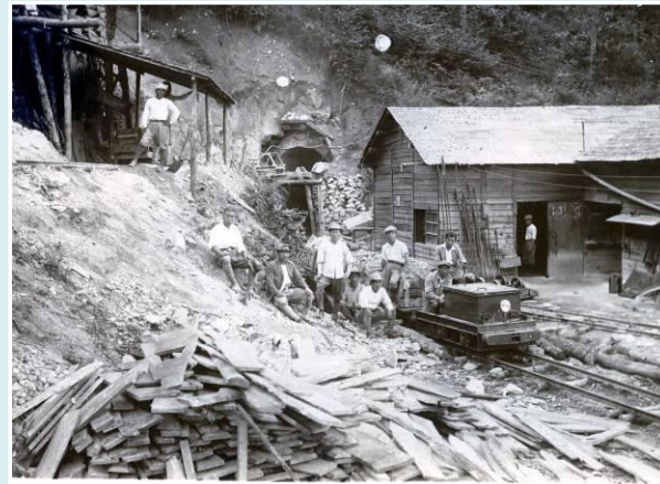
水路トンネル工事
