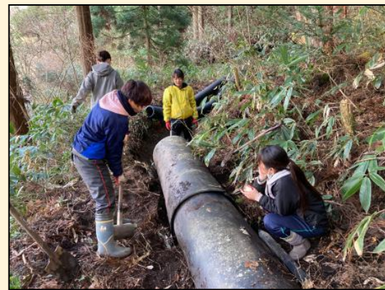
【鳥大学生ボランティアと水路補修】
