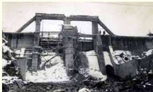
昭和15年建設当時
