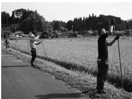
田んぼの畦に支柱を打ち込みます。
