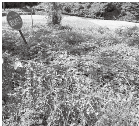
草に埋もれた防火水槽
