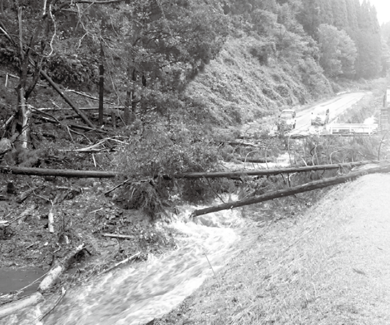
▲2017年10月台風21号による土砂災害
