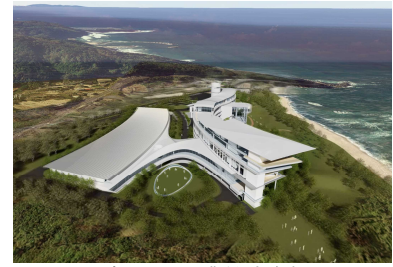
ダイキン工業株式会社 ダイキンアレス技能技術棟の増築 出典：ダイキン工業配布資料より
