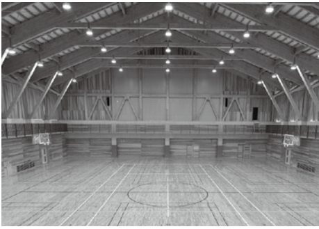
体育館の改築
