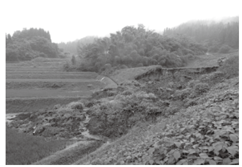
豪雨・台風 24 号による災害
