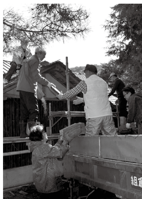
▲バケツリレーの要領で瓦を取り外しました。一つの作業を行う前の準備が効率的な作業に繋がることをこの日は学びました。
