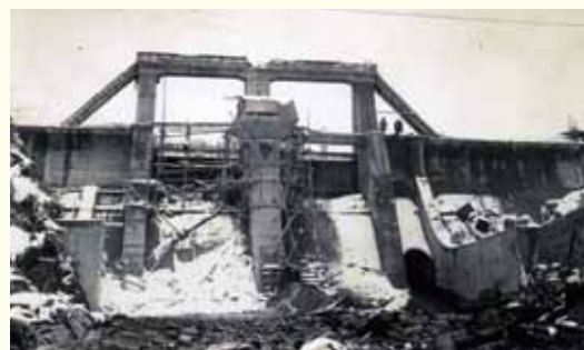
昭和15年建設当時
