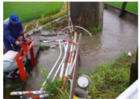
ゲートへのごみや流木の流入状況
