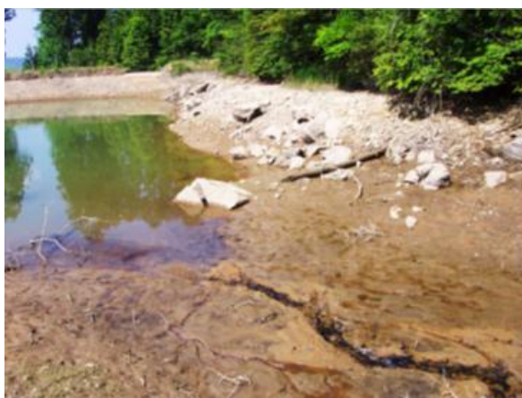
ため池に流入した土砂
