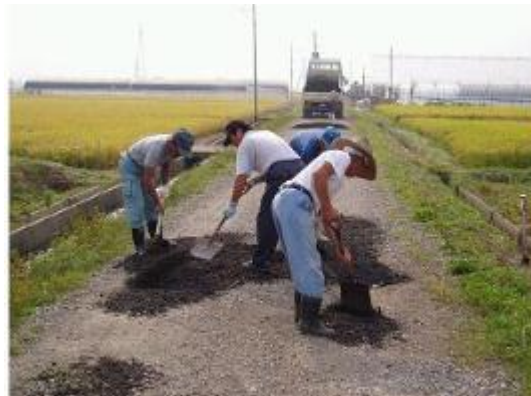
共同作業による砂利の敷き均し
