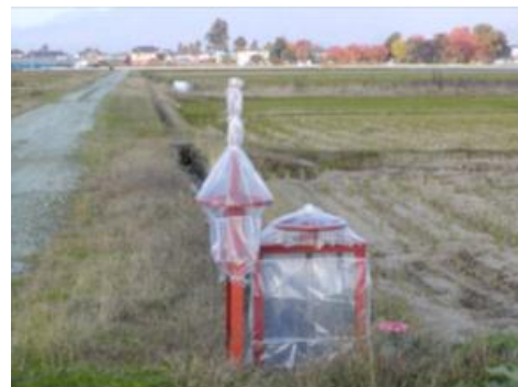
ゲートの被覆状況
