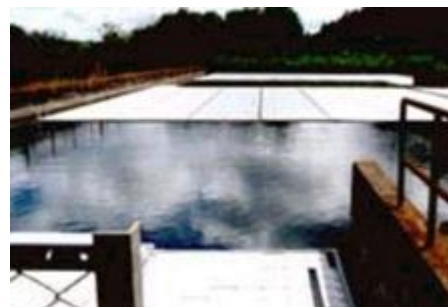
浮揚型の天蓋による部分遮光
