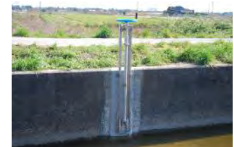
巻き上げ式ゲート（分水用ゲート）
