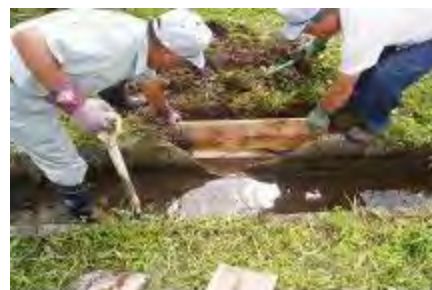
U字溝の改修作業
