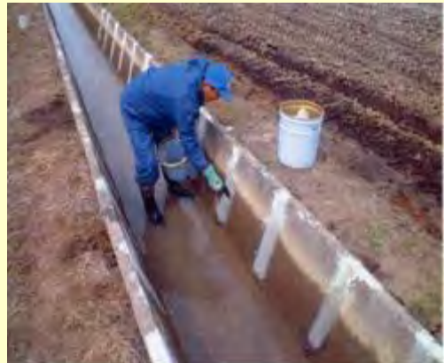
目地詰め作業
