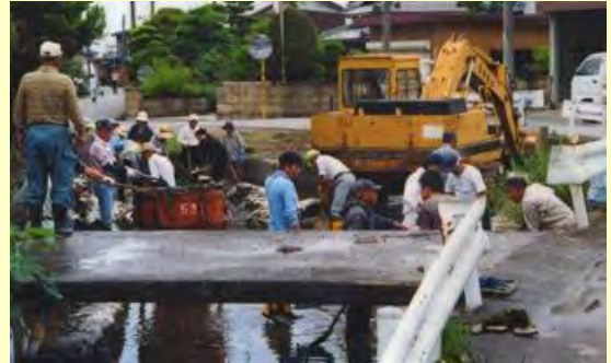
集落での泥上げ作業
