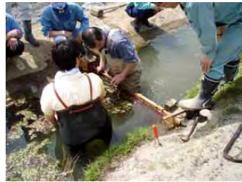
魚道の設置状況（堰板の設置）
