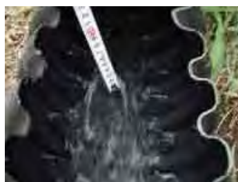
通水試験（水深確認）
