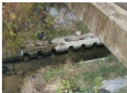
多孔コンクリート護岸
