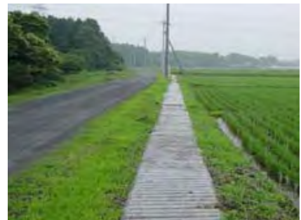
水路へのコンクリート蓋の設置
