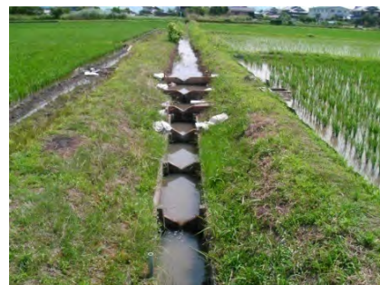
水路魚道（排水路堰上施設）
