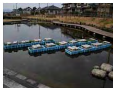
木炭浄化（接触酸化法の一つ）
