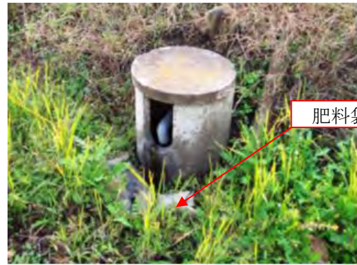
水流を緩和する クッション（肥料袋）の設置
