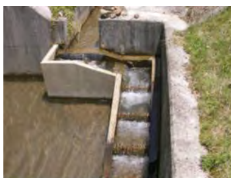
段差解消水路
