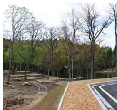
農林業ふれあい施設内の歩道に使われている木材チップ
