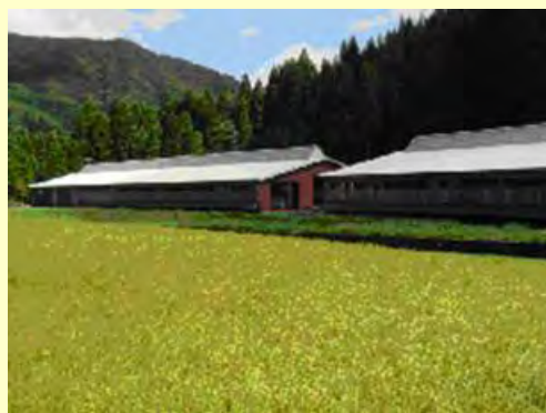
たい肥プラントの外観
