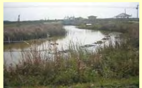
浄化池の状況
