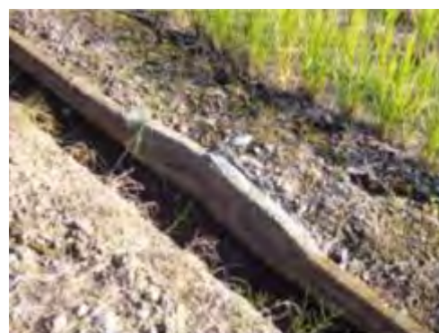
改修したU字溝
