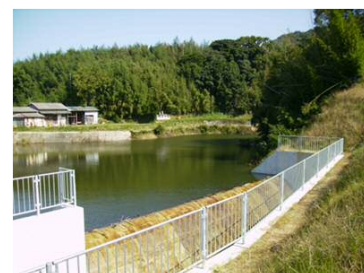
金網フェンスの設置状況
