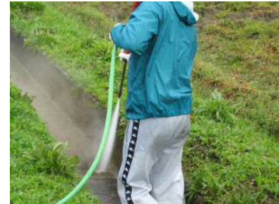
高圧洗浄機による 水路内の清掃
