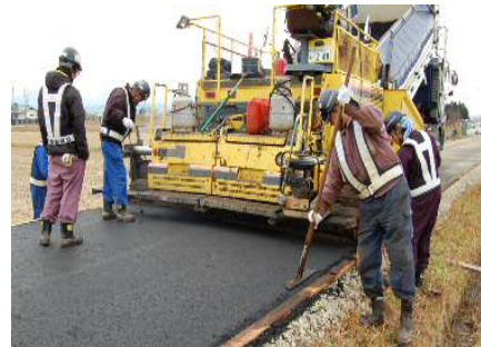
アスファルト舗装状況
