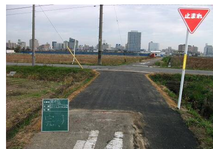
アスファルト舗装の打換え
