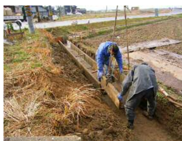
水路の再布設
