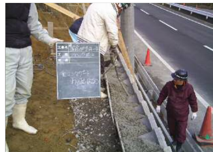
ブロック積みの施工
