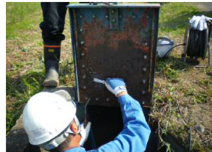
ゲートの補修状況
