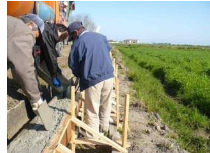
側壁嵩上げ部へのコンクリート打設
