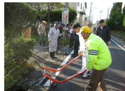
水路蓋の設置 (専用器具使用)
