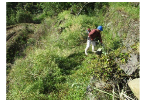
【法面の草払い（共同活動）作業の様子】
