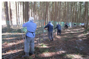
【鳥獣害侵入防止柵設置作業】
