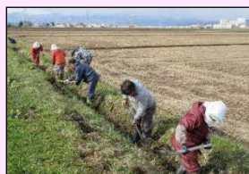
水路の泥上げ
