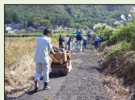
未舗装農道の舗装
