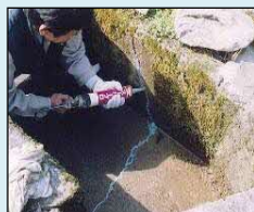
ひび割れの補修
