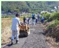
未舗装農道の舗装
