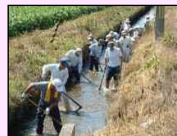
水路の泥上げ
