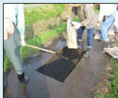
農道の部分補修
