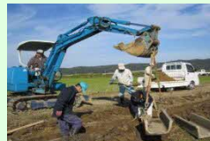
コンクリート水路の更新
