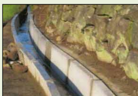
素堀り水路からの更新
