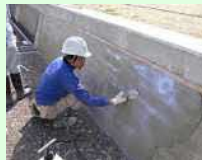
摩耗した水路壁への表面被覆材の塗布
