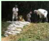
漏水箇所の補修
