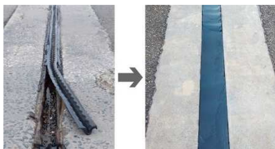
ゴム劣化取替工法〈NETIS:QS-180049-A〉
