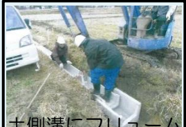
土側溝にフリューム 布設(例)
