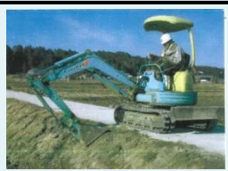
路肩の補修(例)
