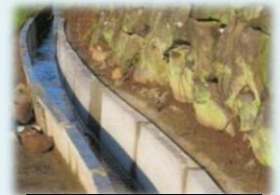
素堀り水路からの更新
