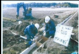
分水柵の補修(例)
