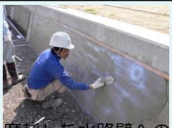
摩耗した水路壁への 表面被覆材の塗布(例)
