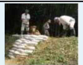
漏水箇所の補修(例)
