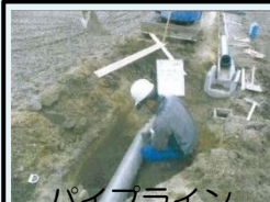
パイプライン の補修(例)
