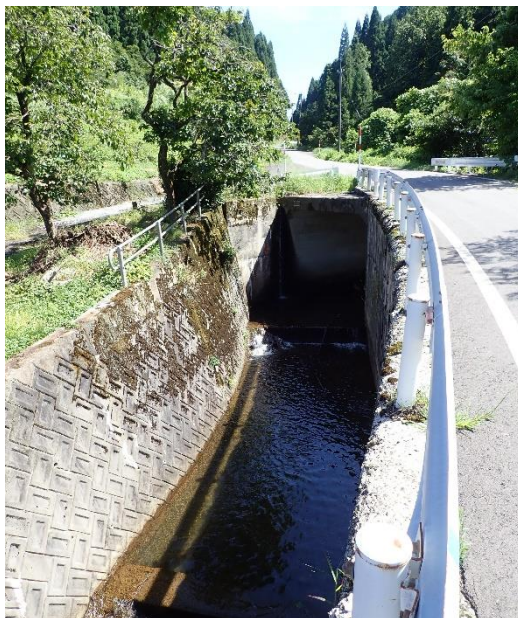
3面護岸（神戸川・日南町）
