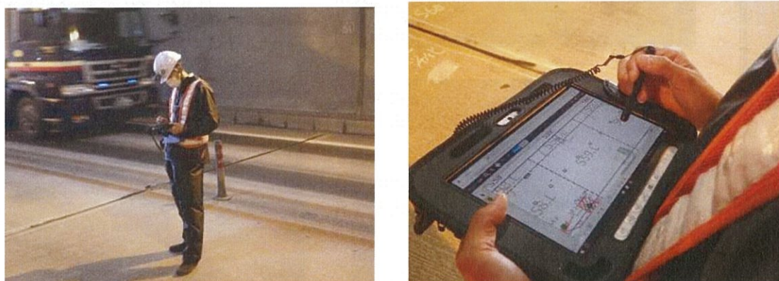
写真8.2 タブレットを用いた現地点検
