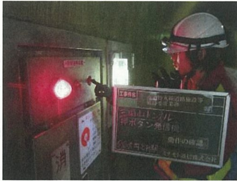
写真 3.1 非常用設備点検状況
