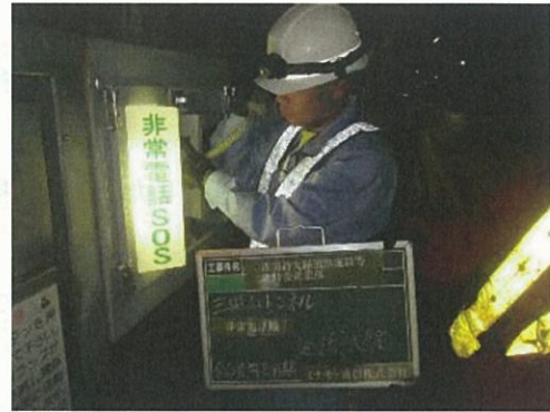
写真 3.1 非常用設備点検状況
