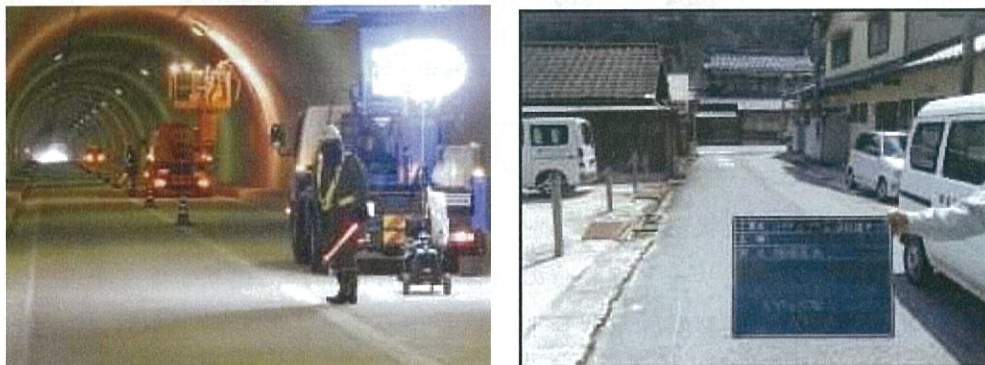
写真 2.1 点検状況写真（左 トンネル点検 右 道路パトロール）
