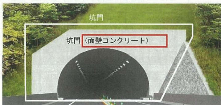
図3.2 トンネル本体工点検箇所
